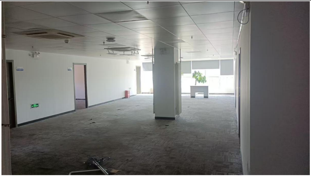
图 2.10 15 号楼五层现状照片
