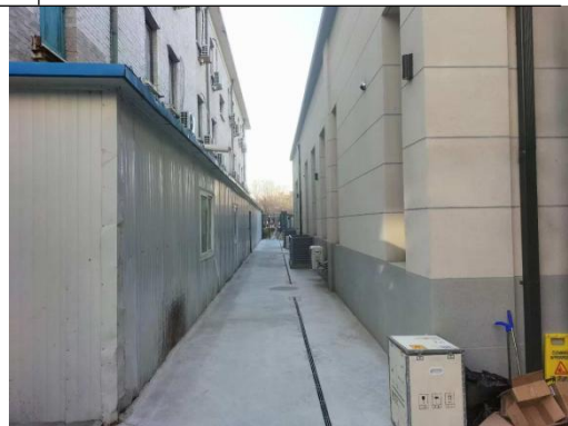
项目南侧道路
